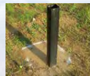
上から土をかぶせれば、景観も損ねない自然な 仕上がりになります
